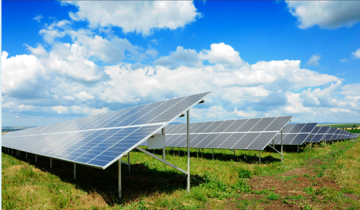
2022 wurde in NRW 62 Megawatt Freiflächen-Photovoltaik zugebaut (vorläufige Schätzung, Foto: panthermedia.net_Fyletto)
